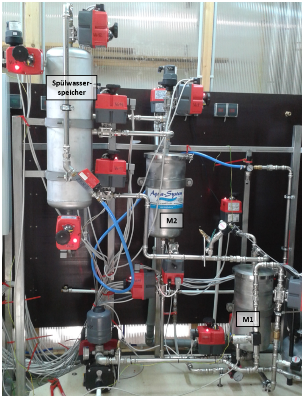
Abbildung 6: Versuchsanlage im Technikum der BOKU Wien
