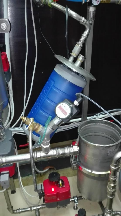
Abbildung 11: Ausbau des Membranmoduls M1
